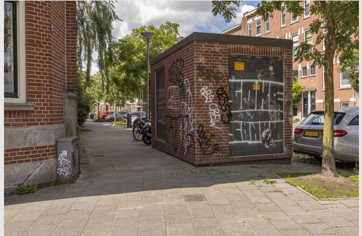
Forse betonnen behuizing omkleed
